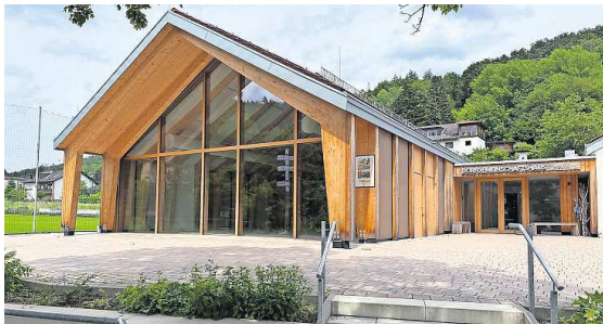
Pflaster am Dorfgemeinschaftshaus muss neu verlegt werden.
