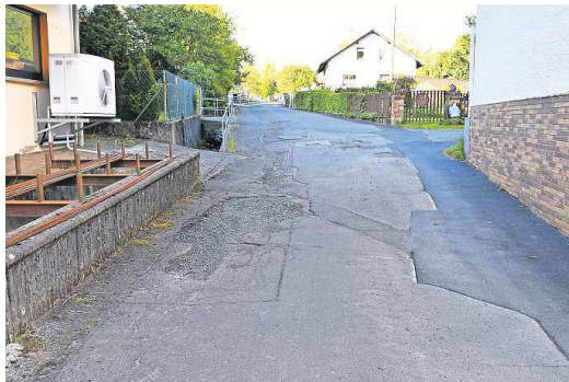
Die Straßenbauarbeiten im Mühlweg sollen im Dezember beginnen.
